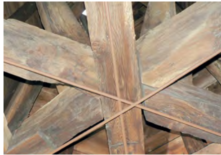
Blick von der Glockenstube aus auf das mächtige Grundgebälk des sechseckigen Turmhelms
