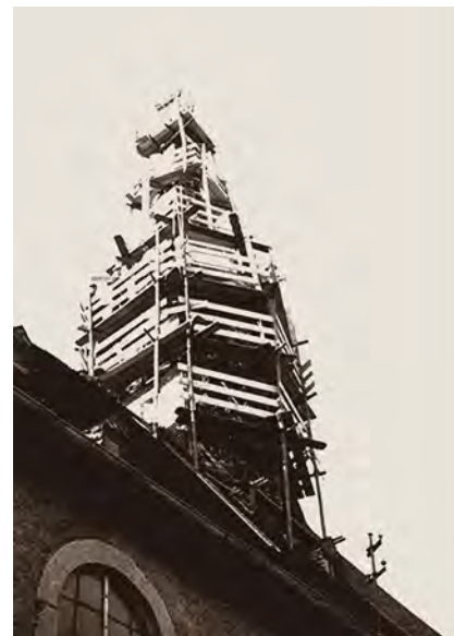
Egelsbacher Dachreiter eingerüstet bis zur Spitze
